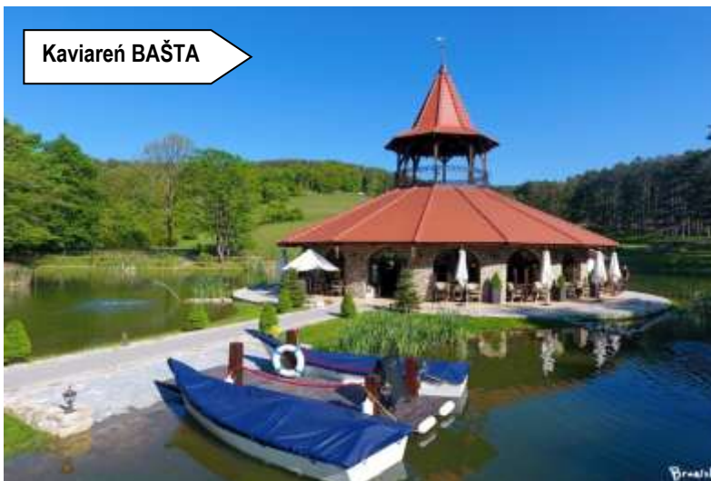
Komplex liečebného domu MIER s japonským átriom a bazénmi
